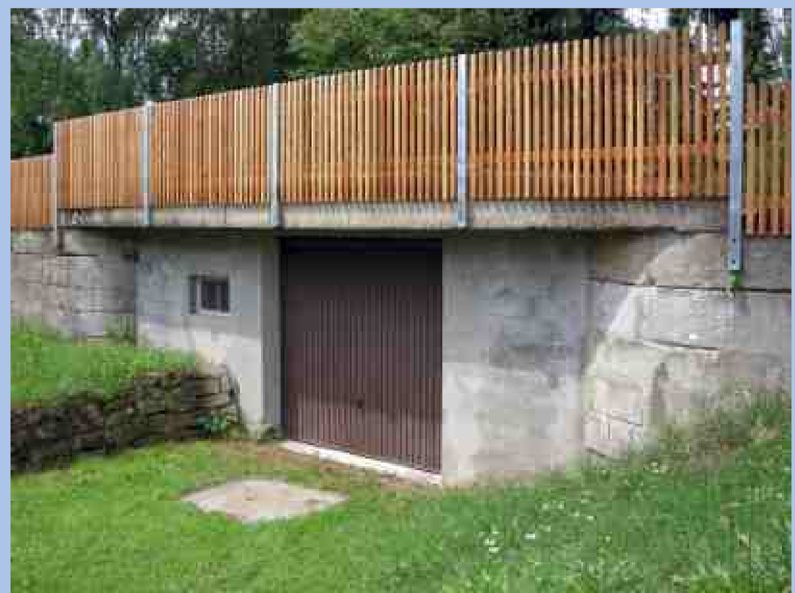
Die Schleuse 99 des Ludwig-Donau-Main-Kanals in Bughof bei Bamberg wurde in den 1960er Jahren umgebaut und dient heute als Garage. (Foto: Robert Schäfer)
